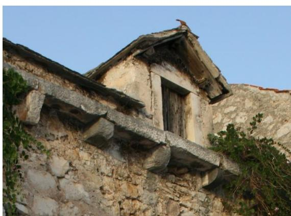
Krovni prozori služili su za provjetravanje *kužine*, koja je bila smještena na tavanu. Nalazili su se uglavnom u središnjoj osi pročelja, a najčešće se radilo o samo jednom *luminariju*. Bio je izgrađen od drvene konstrukcije, s jednostrešnim ili dvostrešnim krovom pokrivenim kamenim pločama. Glavno pročelje *luminarija* obično je zauzimao klasičan dvokrilni drveni prozor podijeljen na šest polja, te zaštićen škurama.
